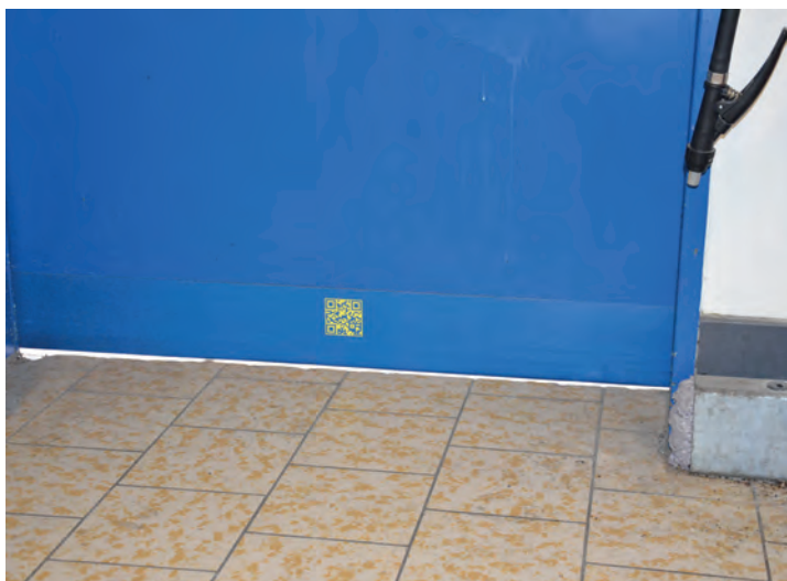
Eén hal van het warehouse is helemaal ingericht met temperatuursensoren
