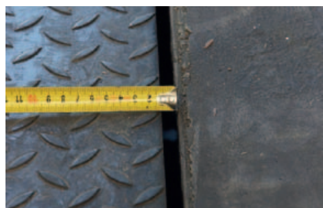
De gemiddelde kierbreedte bij een dockleveler is al gauw 15 mm
