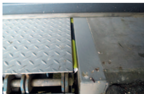
Em-Flex dicht de kier vrijwel hermetisch af
